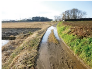
降雨後に冠水した未整備の耕作道
