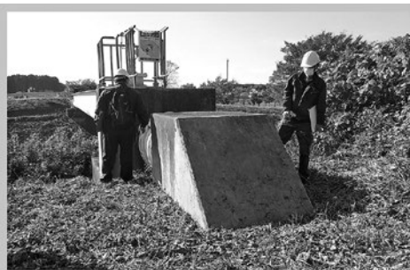
岩井線 飯沼川水管橋点検状況（左岸側）
