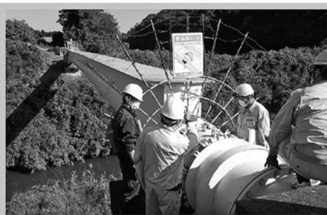
岩井線 飯沼川水管橋点検状況（右岸側）
