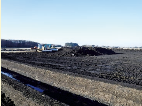
農地を区画拡大するための基盤整地
