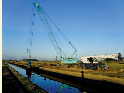
排水樋管改修のための河川締切
