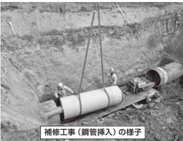
補修工事(鋼管挿入)の様子
