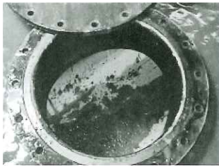
【管内への進入(千代川線)】 空気弁を開放して入管します
