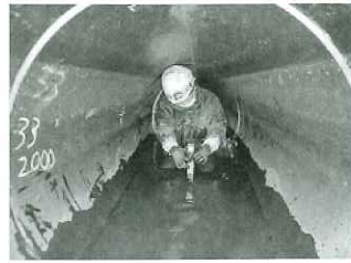
【調査状況(千代川線)】 たわみ量測定状況
