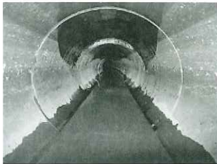
【管内の状況(千代川線)】 クラック等の損傷はありません
