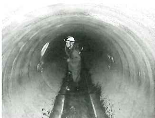
ダクタイル鉄管内部の様子
