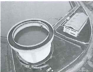
【東山田揚水機場吐水槽全景】
