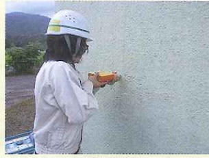
圧縮強度調査
