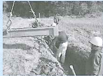
■土水路からコンクリート水路へ
