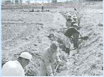
■水路の保全管理
