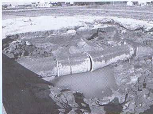
国営名崎幹線2号分水工上流
