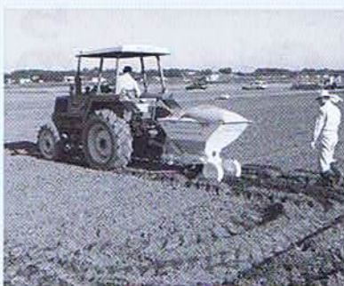
補助暗渠施工状況（坂東市）
