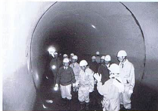
トンネル内見学の状況(1号)
