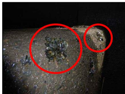
調整池のコンクリート壁に付着したカワヒバリガイ。
